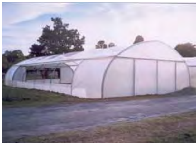
Figura 1. Invernáculo tipo túnel "ADC" con ventanas laterales.
