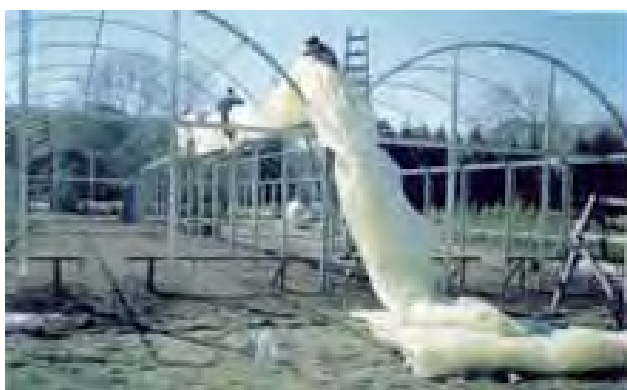
Figura 8. Instalación de cubierta plástica en el vivero Hua Hum, San Martín de los Andes, Neuquén (Foto Enricci 2003).
