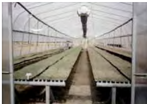
Figura 12. Calefactor interno con distribuidores de aire caliente (Foto Enricci 2008).
