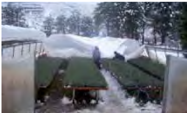
Figura 13. Efectos de acumulación nival por falta de calefacción (Foto Enricci 2008).
