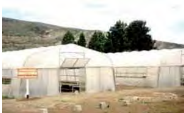
Figura 4. Naves individuales de invernáculos de paredes verticales con cierto ángulo y techo tipo arco gótico en vivero del Paider forestal, UNPSJB, Esquel, Chubut (Foto Enricci 2001).
