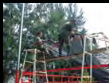
Fotografía 19. Colocación de agromallas sobre las naves.
