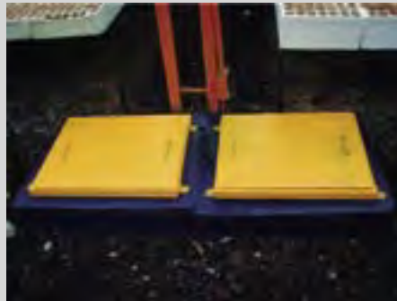
Fotografía 15. Mantenimiento de los registros del riego.
