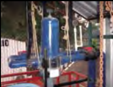
Fotografía 10. Mantenimiento al inyector.
