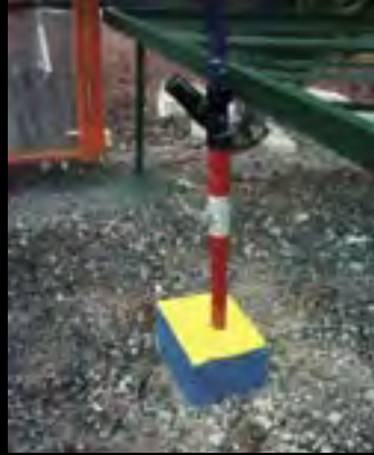
Fotografía 13. Mantenimiento de los filtros de la línea del riego.
