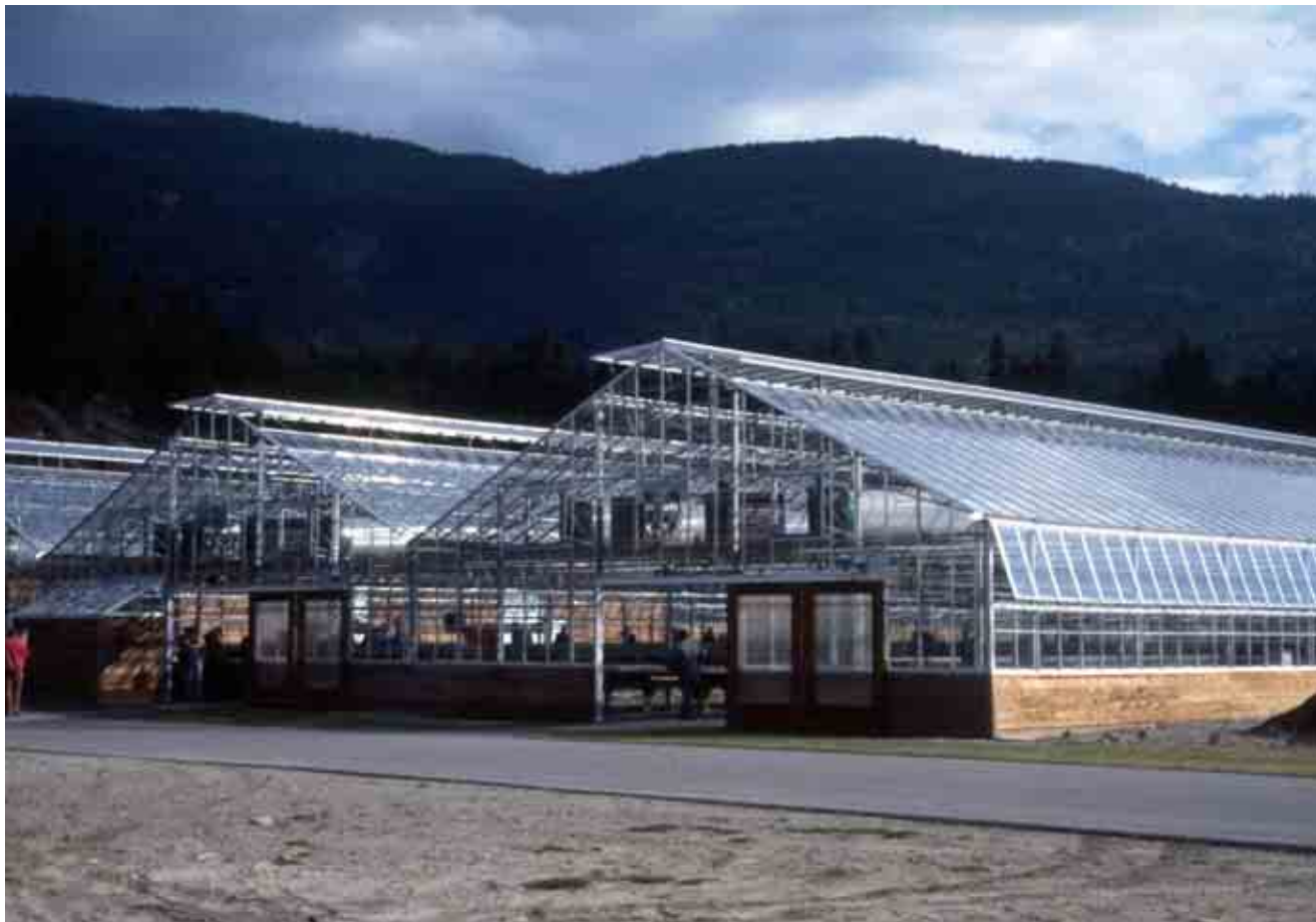
Figura 1.3.15. Los invernaderos de vidrio tradicionalmente han sido muy populares debido a su larga vida, y nuevas tecnologías de producción están haciendo a este tipo de cubiertas aún más prácticas.
